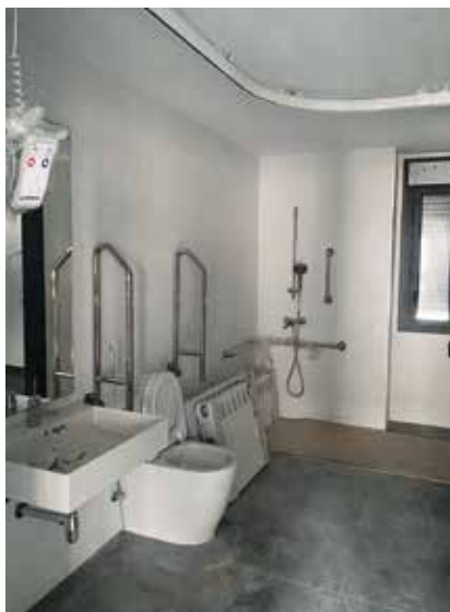
Baño con grúa en las viviendas accesibles que se están construyendo en La Camocha, Gijón.
