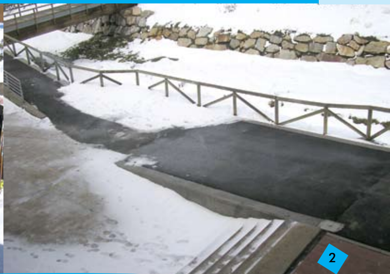
Foto 2. Se ha procedido a compensar el exceso de desnivel que presentaba el itinerario peatonal de acceso a uno de los edificios de Servicios de la Estación.
