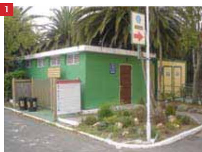
En la foto uno de los edificio destinado a aseos públicos presenta escalones que dificultan el acceso a las personas con movilidad reducida.
