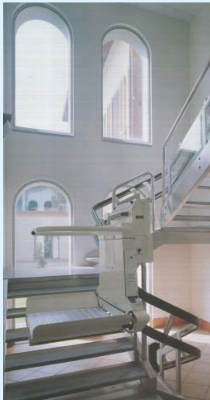
Ejemplo de plataforma montaescaleras/servoescala. Guías fijas ancladas en la escalera, y adosadas a barandilla o pared
