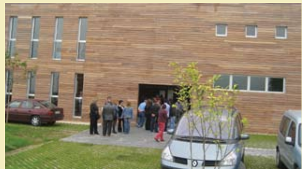
Imagen del Centro de Apoyo a la Integración para Personas con Daño Cerebral Adquirido.
